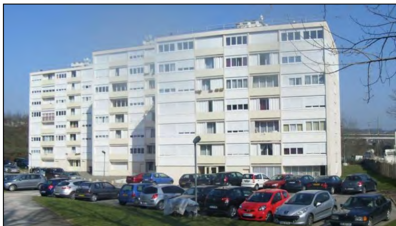
Vue générale côté Ouest : accès aux halls et stationnement
